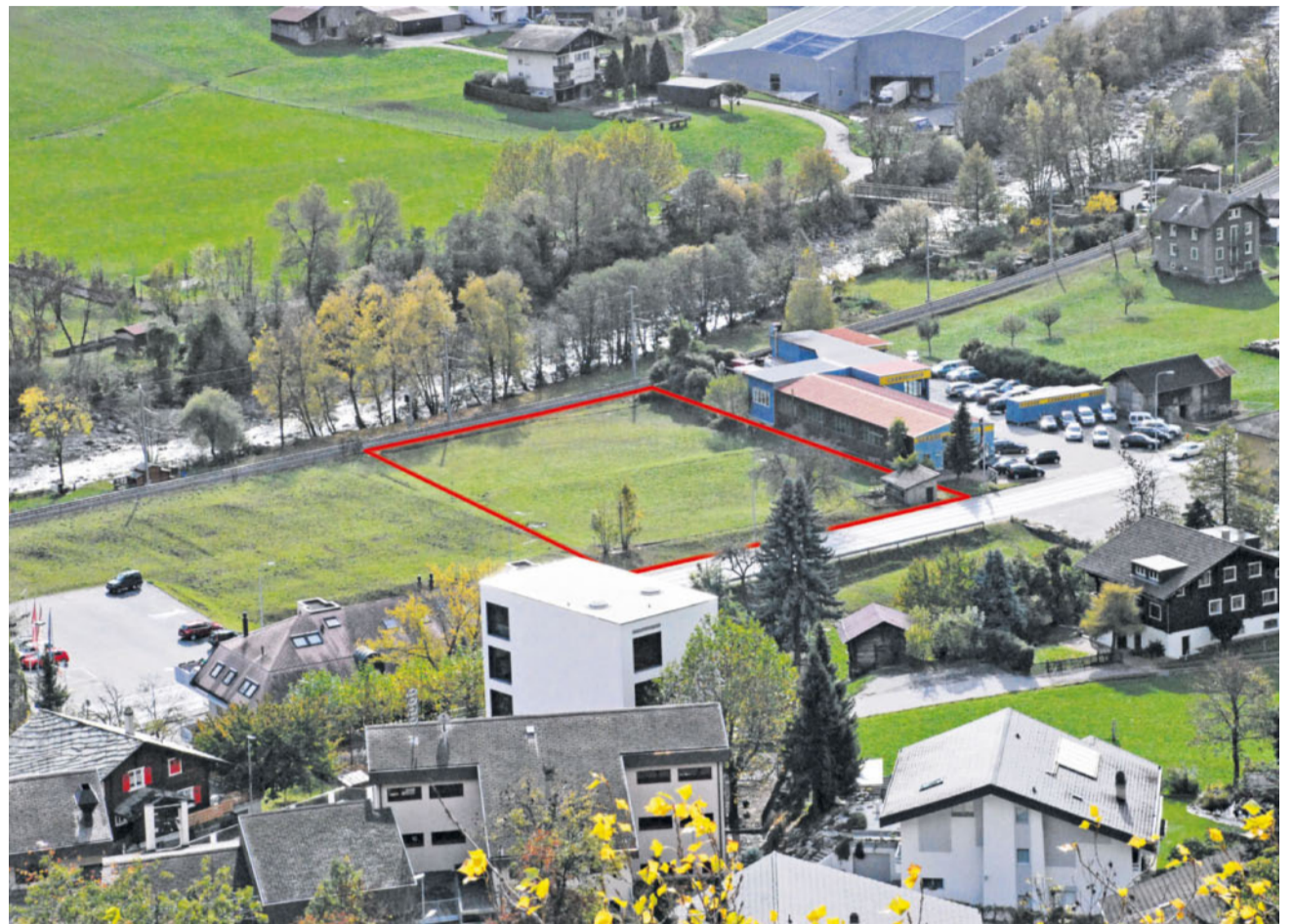
Der Bauplatz. Die gemeindeeigene Parzelle östlich der Garage und Carrosserie Massa ist 2700 Quadratmeter gross und 0,945 Millionen Franken wert.
